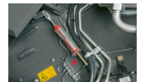
Alla smörjpunkter är samlade till centrala smörjpintar och är tydligt markerade.
